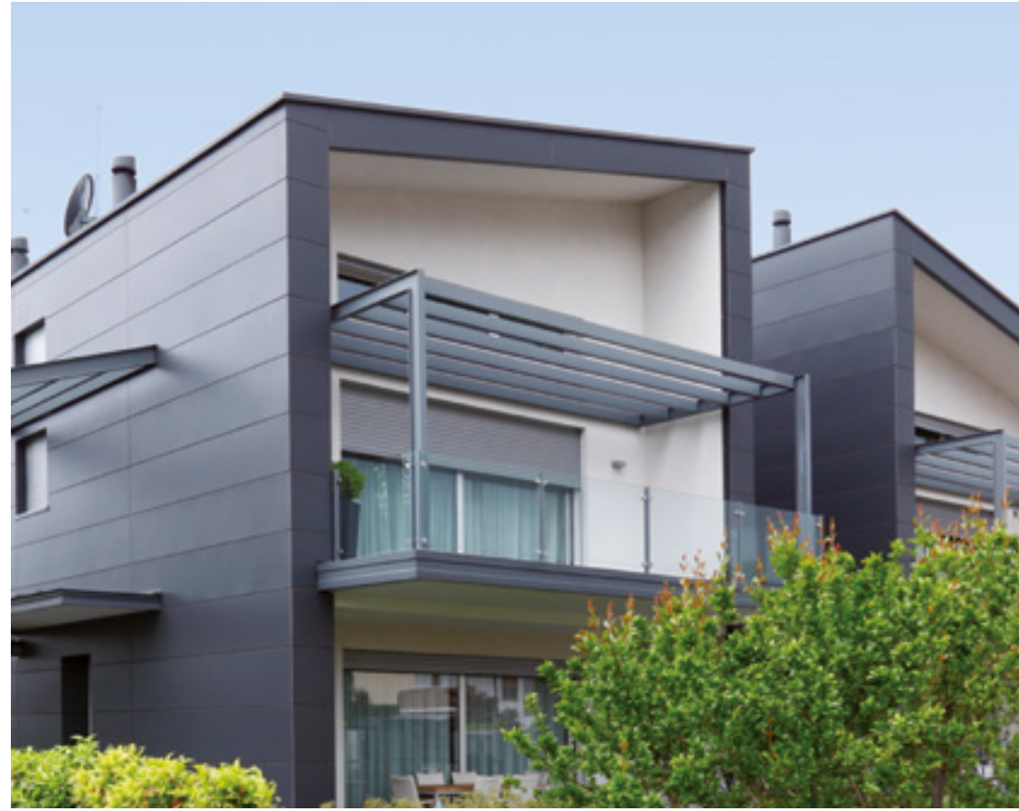
why be normal/ Ahrntaler Fassaden-Balkone
